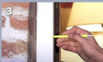
Après avoir repéré l'emplacement des trous de fixation des glissières, percer les murs, puis fixer le volet en place
