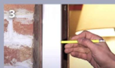
**Dans le cas de la pose C :** les glissières ne sont pas percées, il faut donc les percer avec une mèche à métaux (3 à 4 trous sur la hauteur).
