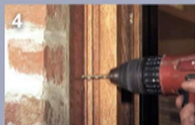
Après avoir repéré l'emplacement des trous de fixation des glissières, percer les murs, puis fixer le volet en place
